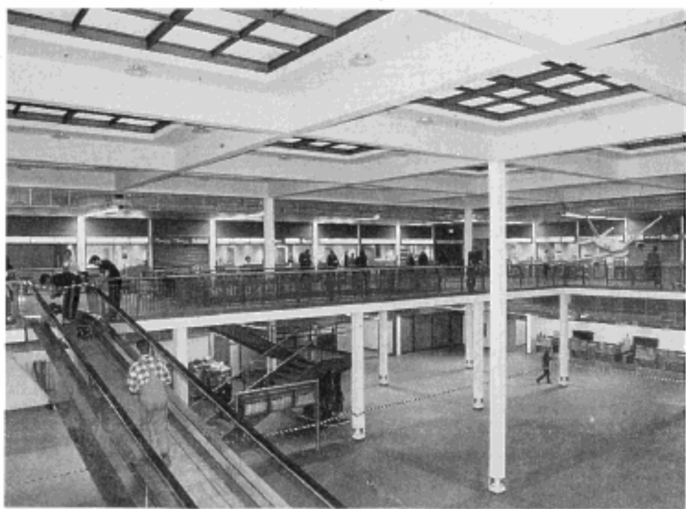
Vor der Eröffnung: Feinschliff bis zur letzten Minute in dem neuen Abfertigungsgebäude
